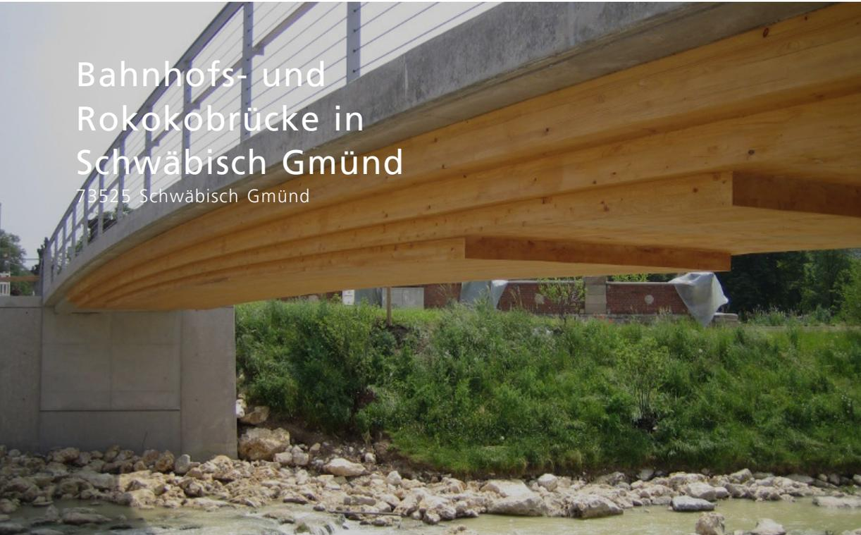
Zwei fast baugleiche Holz-Beton-Verbundbrücken bereichern das Stadtbild von Schwäbisch Gmünd. Die Brücken zeichnen sich durch einen raffiniert gestuften Holzträger aus, der zur Feldmitte hin den größten Querschnitt von knapp 60 cm aufweist. Es sind integrale Bauwerke, das heißt Rahmentragwerke ohne Fugen und Lager. Dies bedeutet: Sie sind wartungsfrei.
