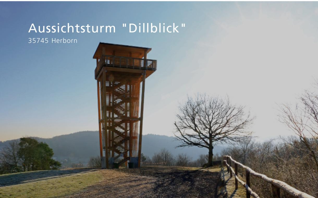
Die Konstruktion des Turms "Dillblick" in Herborn besteht aus zwei in sich geschachtelten Fachwerkquadern, die nach oben hin breiter werden. Der viergeschossige Turm wurde aus Douglasien-Brettschichtholz gefertigt, ist 17 m hoch und hat eine Grundfläche von 6 m x 6 m.
