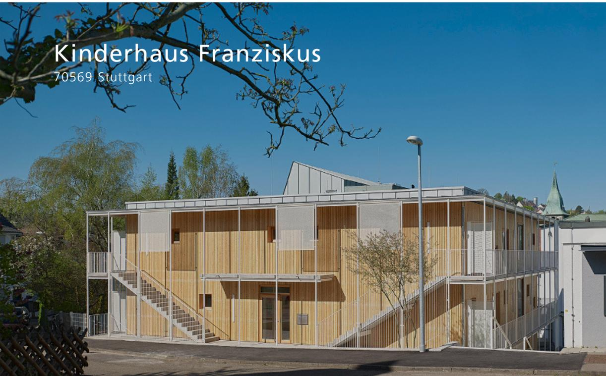
Das Kinderhaus Franziskus ist ein dreigruppiger Kindergarten mit Ganztagesbetreuung. Das Gebäude besteht aus einem dreigeschossigen Kubus in Holzständerbauweise. Die umlaufenden Fluchtbalkone sind als Stahlkonstruktion mit der Brandschutzanforderung F-30 ausgeführt, mit Betonfertigteilen als Laufflächen. Sie bieten zugleich einen konstruktiven Holzschutz für die Holzfassade.
