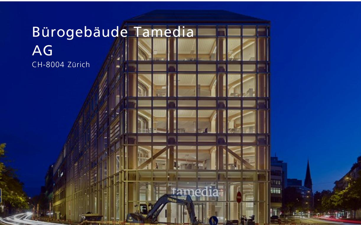
Das siebengeschossige Bürogebäude des Medienkonzerns Tamedia im Zentrum Zürichs ist außergewöhnlich: Die Holzkonstruktion kommt ganz ohne Schrauben, Nägel und sonstige Stahlverbinder aus. Sie ist nur zusammengesteckt und im Inneren überall sichtbar. Die Entwurfsidee des japanischen Architekten Shigeru Ban lehnt sich an die traditionelle japanische Holzbaukunst an. Sein Wunsch nach Nachhaltigkeit und Transparenz in der Architektur passte zur Firmenphilosophie des Bauherren.
