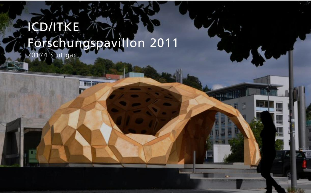
Aus über 500 schmalen Birkenholzelementen wächst ein luftiger Pavillon auf dem Uni-Campus in der Stadtmitte. Sein ästhetisches Äußeres entstand durch neue Entwurfs- und Herstellungsmethoden, die diese Konstruktion erst ermöglichten. Der innovative Bau demonstriert den neuesten Stand der Entwicklung computerbasierter Entwurfs-, Simulations- und Produktionsprozesse in der Architektur und setzt diese in einer komplexen Tragkonstruktion aus elastisch gebogenen Sperrholzstreifen um.
