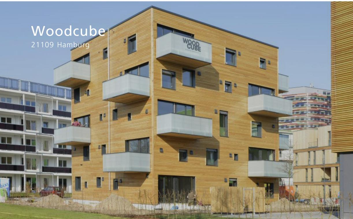
Der Woodcube ist als herausragender Beitrag im Rahmen der Internationalen Bauausstellung in Hamburg 2013 errichtet worden. Die unverleimte Vollholzkonstruktion besteht aus 35 cm starken unbehandelten Aussenwänden, welche Brandschutzkapselung, Statik und Wärmedämmung in einem massiven Element darstellen, Die Decken und Balkone bestehen aus 25 cm starken, ebenfalls unverleimten, Massivholzelementen. Der erhöhte Schallschutz und der Passivhausstandart wird erreicht.
