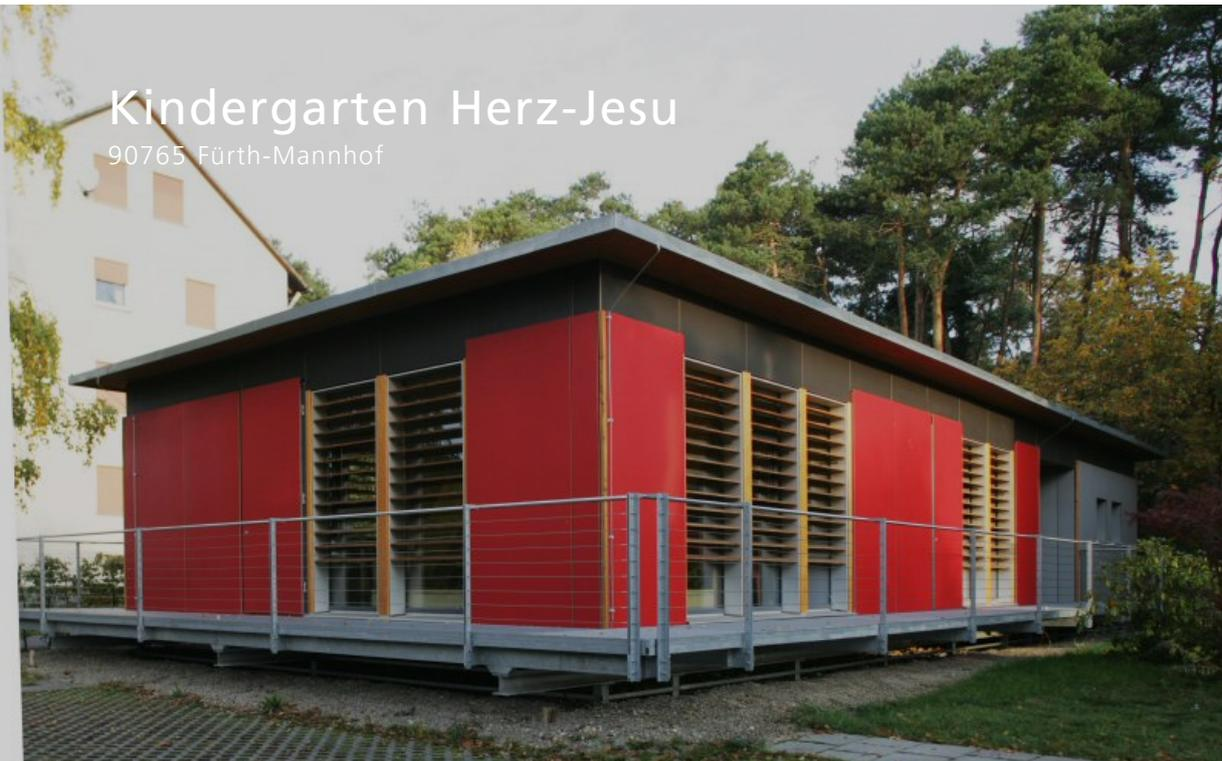
Das Konzept beinhaltet Module in Holztafelbauweise als Raumzellenkonstruktion. Das Gebäude besteht aus acht Einzelzellen, passt auf vier Tieflader und ist ohne Sondergenehmigung transportierbar. Durch die Vormontage und Vorinstallation ist das Gebäude in kürzester Zeit montierbar.
