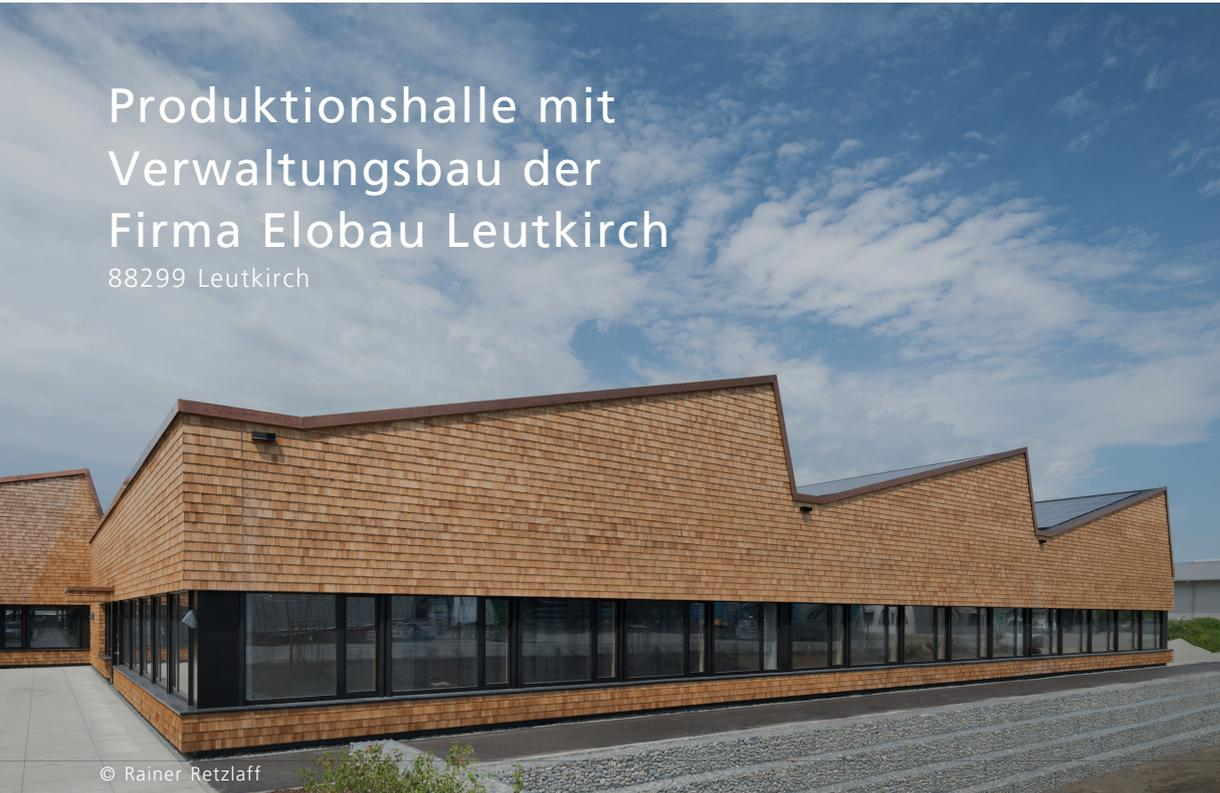
Der Erweiterungsneubau des Werkes II der Firma Elobau umfasst zwei Hallen mit Produktions- sowie Büroarbeitsplätzen im Energie-Plus-Standard in Holzbauweise. Bei dem Gebäude handelt es sich um eine Bestandserweiterung in zwei Bauabschnitten. Insbesondere die für einen Industriebau ungewöhnliche, bis in die Dachebene hochgeführte Holzschindelfassade gibt den Baukörpern im Kontext mit den insgesamt sieben Reitern des Sheddachs eine besondere Architektursprache.
