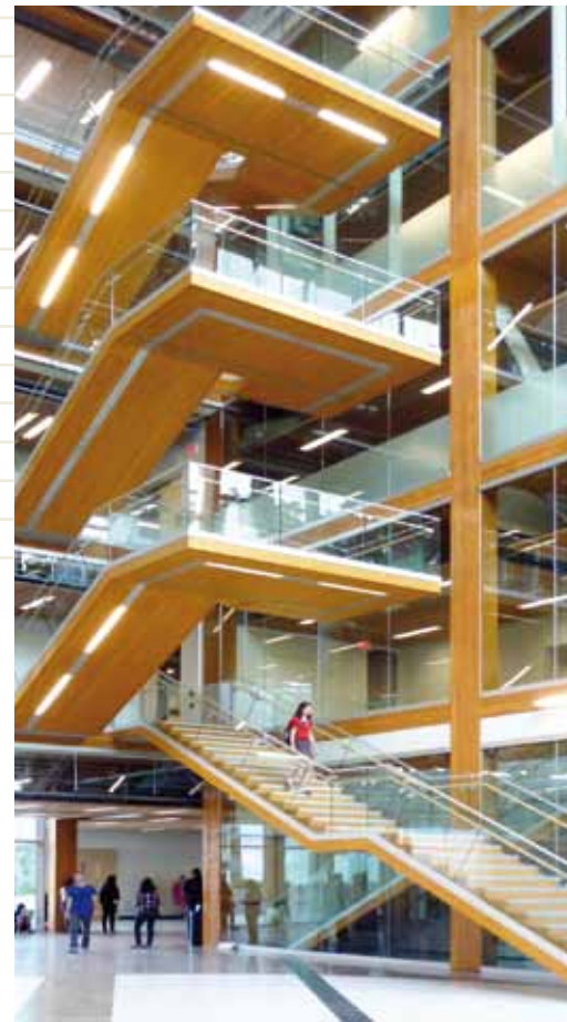
Freitragende und auskragende Treppe an der Universität in Vancouver (CA). Die biegesteifen Anschlüsse der Treppen- läufe an die Geschossebenen und die Podeste bestehen aus Holz-Lochblech-Verklebungen.
