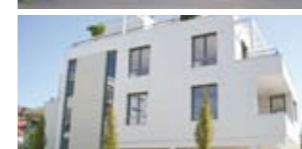
Neubau Wohn- und Geschäftshaus Hofheim Axel Wintermeyer Frank & Jens Härder
