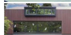
Sanierung Vogelschutzwarte Frankfurt Hessen Forst
