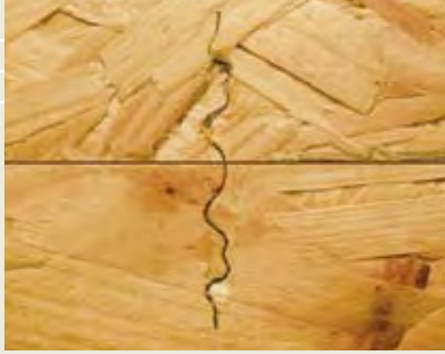
Schubsteif verbundener Plattenstoß
