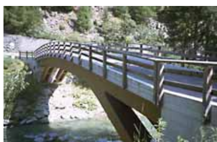
Bild 1b Crestawaldbrücke zu Militärdepot bei Sufers (CH)
