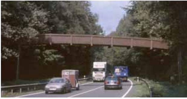
Bild 6a Fußgänger- und Radwegbrücke Münster (1962)
