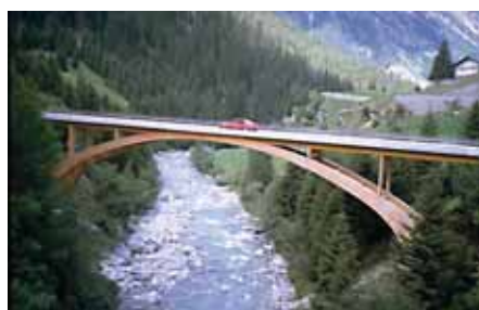
Bild 1a Straßenbrücke über den Averser Rhein Innerferrera (CH)
