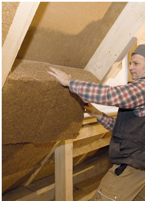
Abb. 29: Zwischensparrendämmung mit flexiblen Holzfaserdämmplatten
