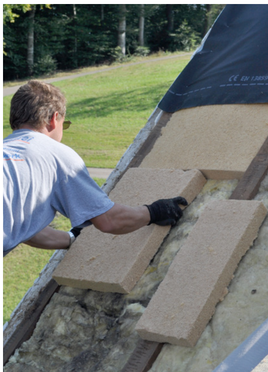
Abb. 34: Füllung der kompletten Sparrenhöhe mit flexibler Holzfaserdämmung
