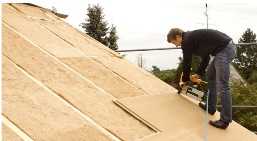
Abb. 18: Verlegung und Fixierung von Holzfaser-Unterdeckplatten direkt auf den Sparren
