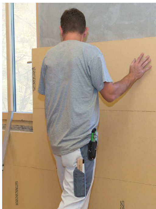
Abb. 44: Energetische Sanierung im Bestand mit verputzbaren Innendämmsystemen
