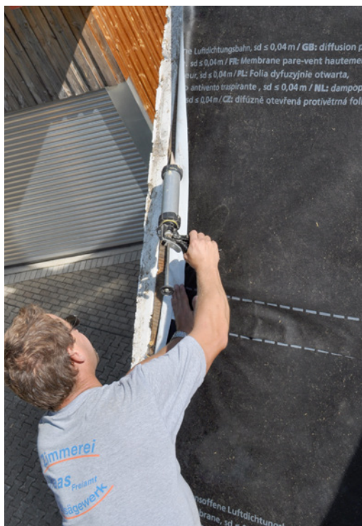
Abb. 35: Luftdichter Anschluss an die Giebelmauer
