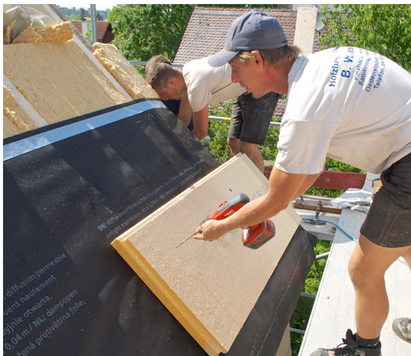
Abb. 36: Dachmodernisierung von außen – flexible Holzfaserdämmung als Gefachdämmung, diffusionsoffene Luftdichtungsbahn, Holzfaserdämmplatte als Unterdeckung
