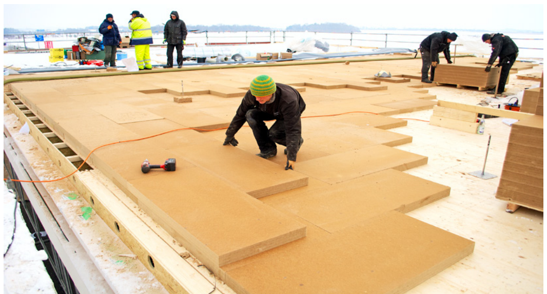
Abb. 30: Verlegung von druckfesten Holzfaserdämmplatten für das Flachdach
