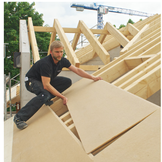
Abb. 15: Verlegung von Holzfaser-Unterdeckplatten
