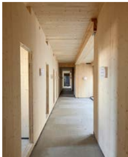
Abb. 9: Holzrohbau aus Massivholzelementen
