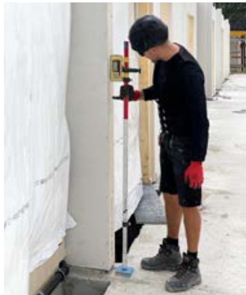
Abb. 31: Kontrolle von Toleranzen im Baufortschritt
