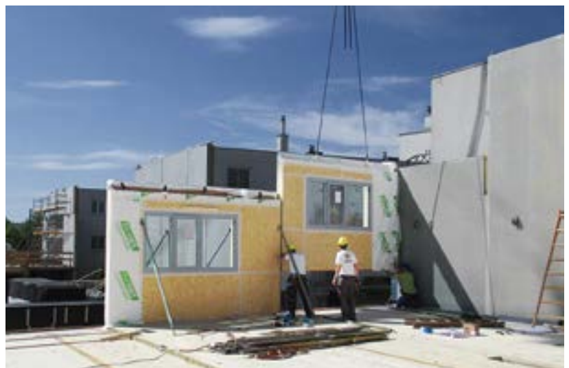
Abb. 25: Holz an Beton: „Die Anschlüsse müssen stimmen...“
