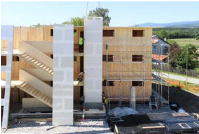
Abb. 28: Montage von vorgefertigten Aufzugschachtwänden
