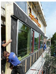
Montage vorgefertigter Fassadenelemente bei der Sanierung eines Schulgebäudes. (Foto: Anton Ambros GmbH)
