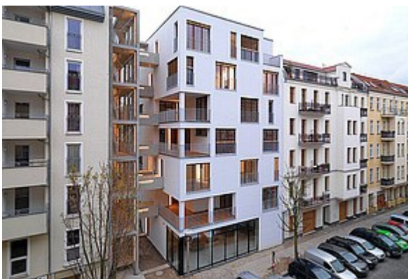
Mehrfamilienhaus in Berlin-Prenzlauer Berg. Dieses Gebäude ist das bundesweit erste siebengeschossige Mehrfamilienhaus in Holzbauweise (Foto: Kaden Klingbeil Architekten)
