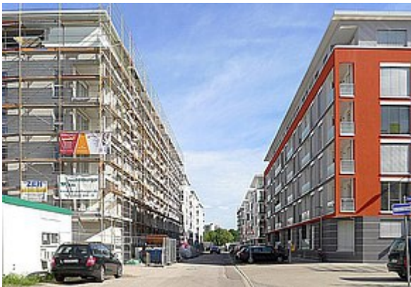
Horizontale Schichtungen erzeugen großvolumige Baublöcke (Foto: Peter Cheret)
