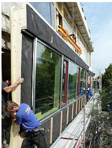
Montage vorgefertigter Fassadenelemente bei der Sanierung eines Schulgebäudes. (Foto: Anton Ambros GmbH)
