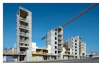
Montage Wohnbebauung in Wien.
